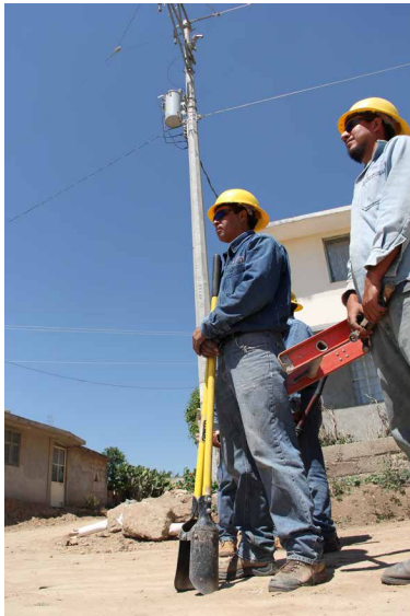
Más de 30 millones de pesos en obras de electrificación.
