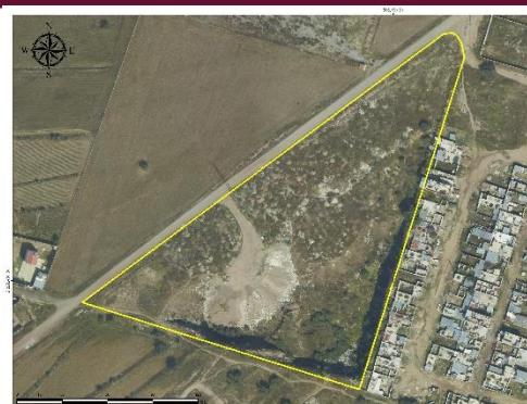
Figura IV.45. Tiradero de Escombros de material en colonia Margarita Moran Véliz.
